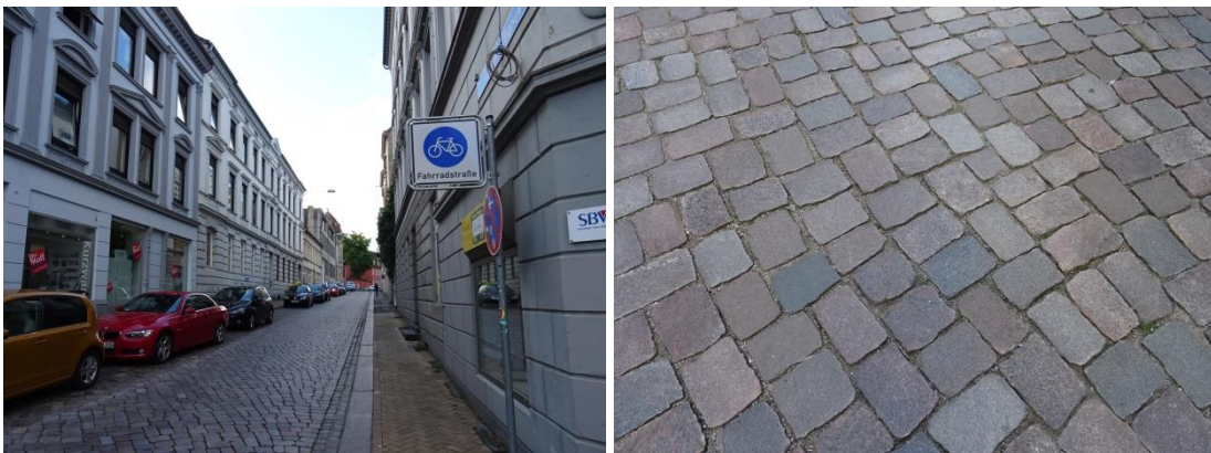
Abbildung 1: Geschliffenes, diagonal verlegtes Natursteinpflaster in der Viktoriastraße (Foto: LK Argus)
